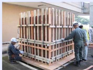
「型枠の組立て・解体」
