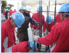
「柱筋の組立て」
