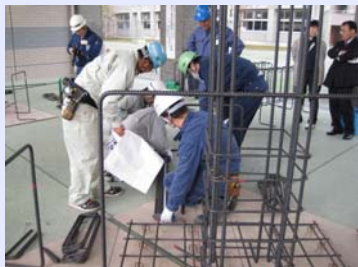
「鉄筋の組立て」
