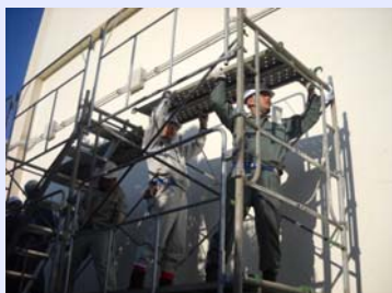
「足場の組立て・解体」
