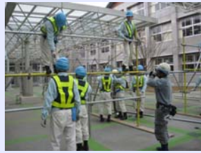
「梁および屋根の組立て」
