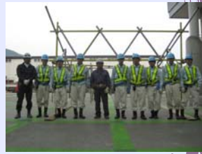
「小屋組み組立て完了」
