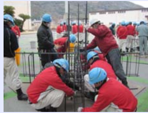
「梁筋の組立て」
