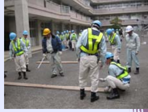
「敷板と単管ベースの設置」
