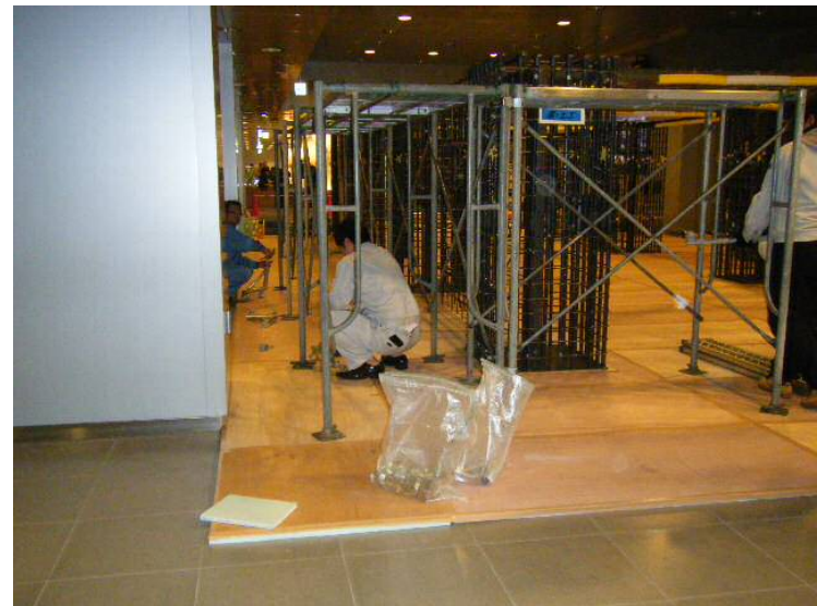
足場組立状況
