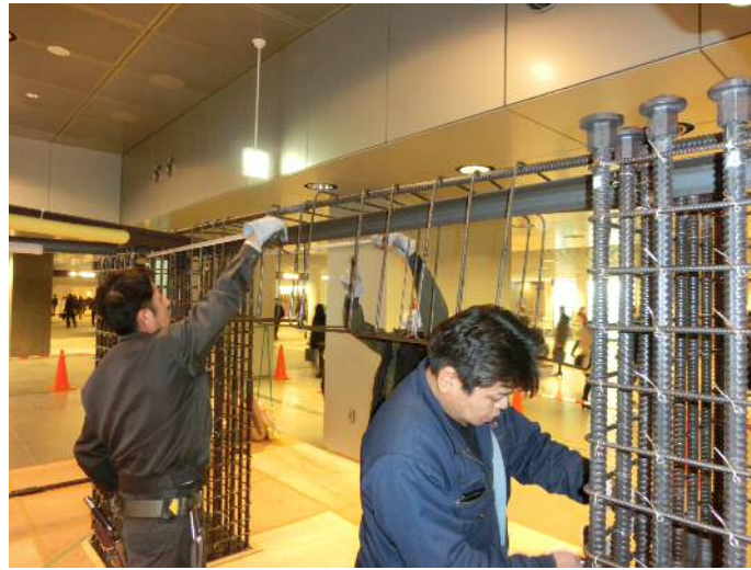
鉄筋組立状況
