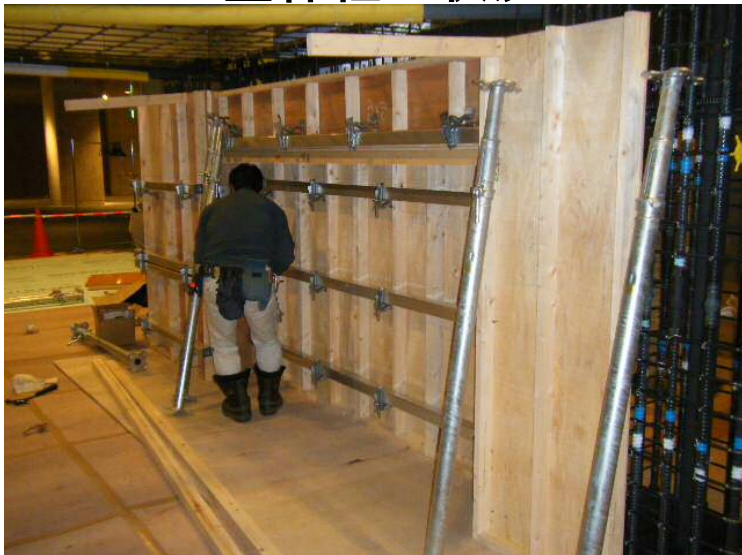
型枠組立状況
