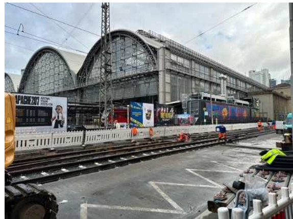
写真（フランクフルト中央駅）
