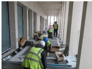
屋外作業風景
