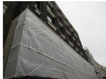
工事現場外観
