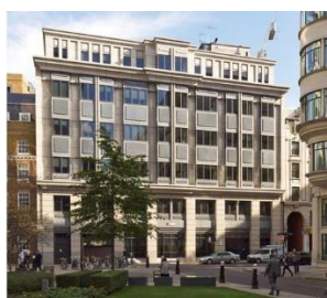
元々のビル（55 Moorgate）
