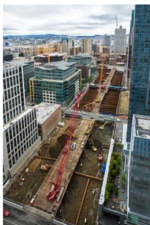
トランスベイ・トランジット・センター新築工事
