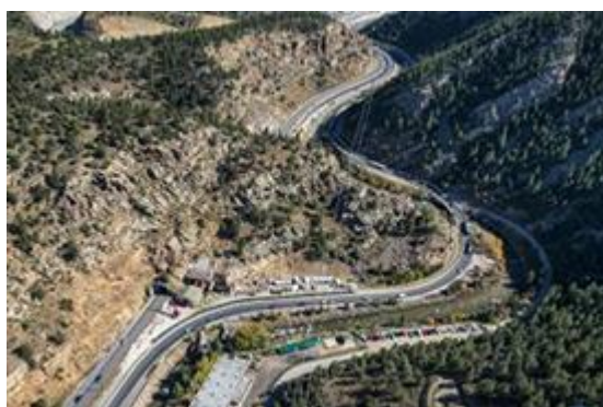
I-70 トンネル拡幅工事
