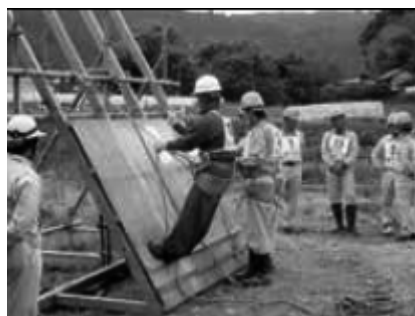
のり面からの墜落災害防止のための 安全帯フック掛け
